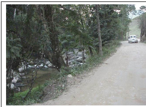
38: Estrada ruim e em área de preservação permanente do Rio
