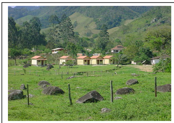
47: Pousada com vários chalés em fase de acabamento
