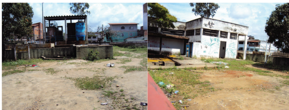
Figura 4-36: Vista da ETE Aeroporto.
