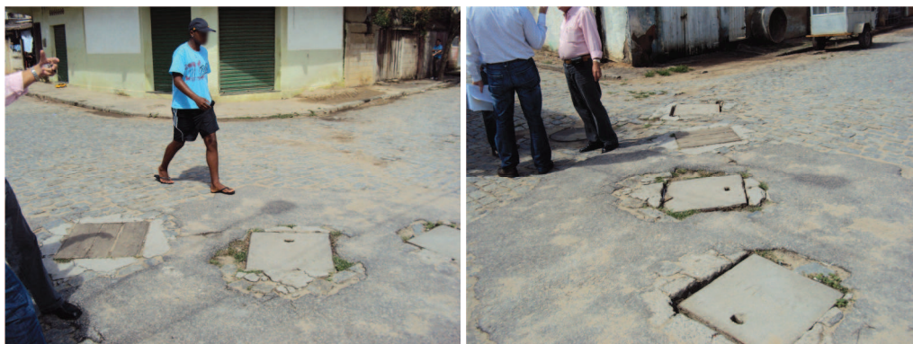
Figura 4-41: Sistema Fossa-Filtro-Sumidouro – Bairro Fronteira.
