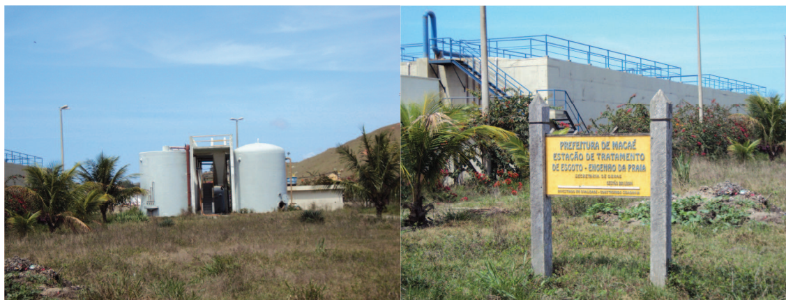
Figura 4-40: Vista da ETE Engenho da Praia.
