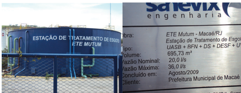
Figura 4-34: Vista da Estação de Tratamento de Esgotos ETE Mutum e placa com dados.
