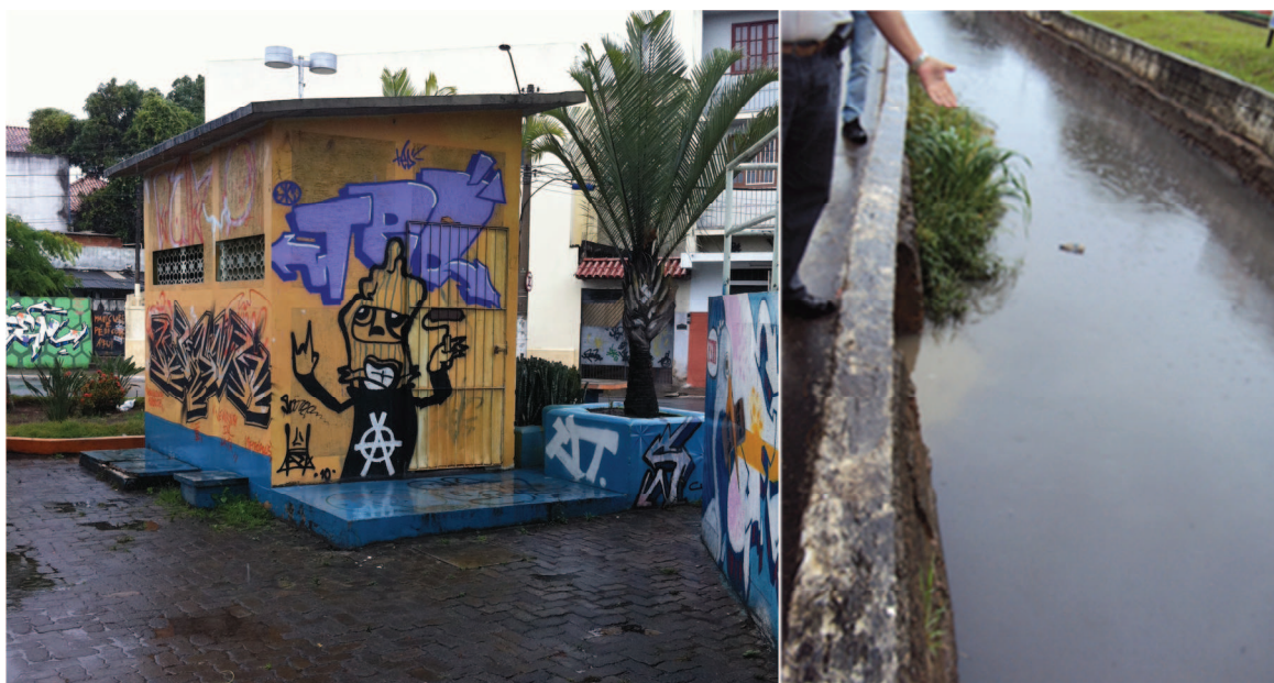
Figura 4-30: Elevatória Miramar e local do deságue do esgoto.
