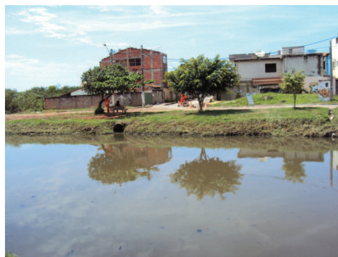
Figura 4-35: Vista da Elevatória Vila Badejo.
