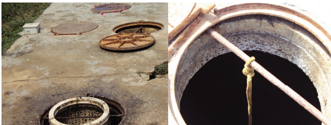
Figura 4-39: Vista da Elevatória Final de Engenho da Praia.
