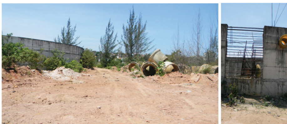
Figura 4-33: ETE Virgem Santa – estado atual.
